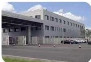
工場・物流倉庫
